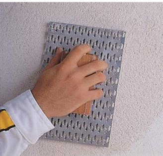
Realizar el acabado (raspando, fratasando, gota...) cuando Hydromur haya adquirido la consistencia necesaria (de 1 a 6 horas después de su aplicación). Hydromur puede cubrirse con materiales muy respirables.
