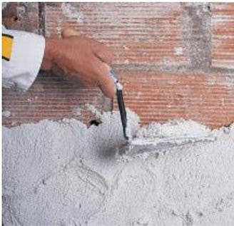
Sobre el soporte húmedo, proyectar Hydromur con una paleta a modo de salpicado, hasta conseguir un espesor mínimo de 2 cm en cualquier punto. Seguidamente regar el producto sin apretarlo, para evitar cerrar el poro. Si necesitamos mayor espesor del producto para conseguir planeidad, aplicaremos Hydromur en dos capas con un espesor mínimo total de 4 cm, colocando una malla entre capas tipo sandwich.
