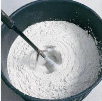
Amasar Hydromur con 5-6 litros de agua limpia, con un batidor eléctrico lento (500 rpm), durante al menos 5 minutos, hasta que la masa este perfectamente homogenizada.
