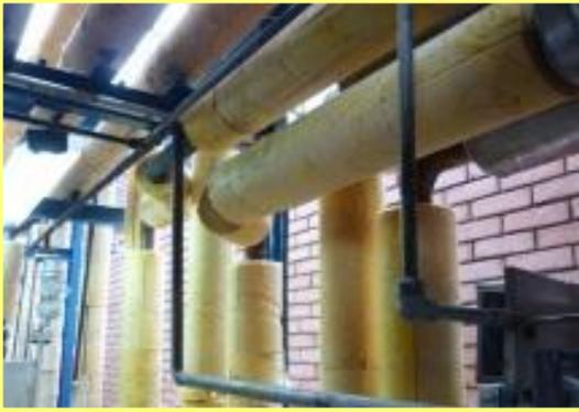
Aislamiento acústico y térmico de lana mineral de vidrio biosoluble rígida, preformada, presentada en secciones de área transversal semicircular, en dimensiones ajustadas a los diámetros externos reales de tubos de acero comercial. El material consiste de fibras de vidrio aglomeradas con resina termo-resistente. La cara externa puede llevar una barrera de vapor tipo foil de aluminio reforzado con malla de fibra de vidrio y papel kraft (FRK).
